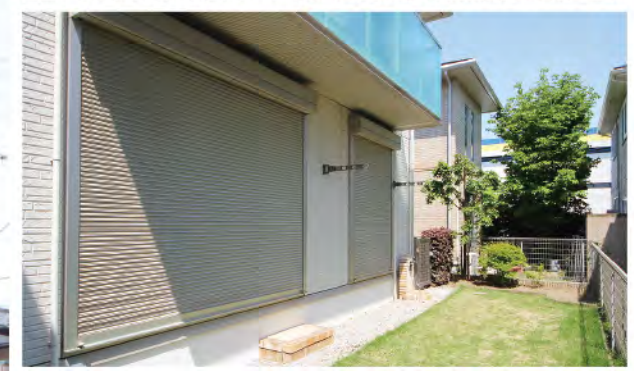
リビング南側のシャッター雨戸は電動式。窓を明けずに開閉が可能です
